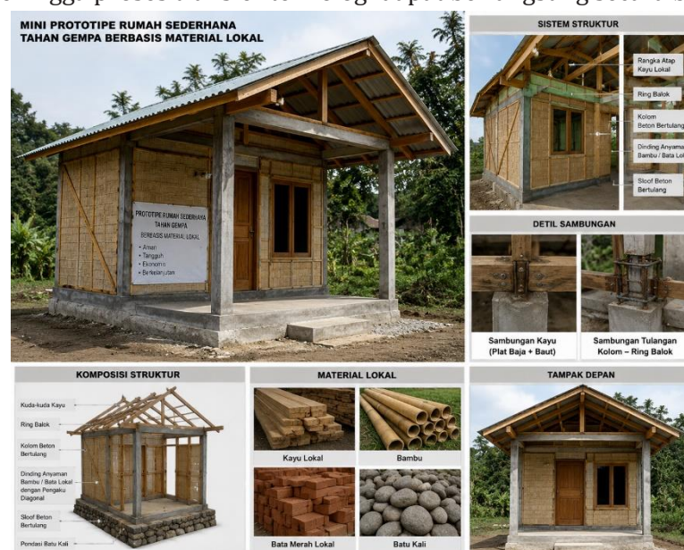
Gambar 2. mini prototipe rumah sederhana tahan gempa berbasis material lokal
